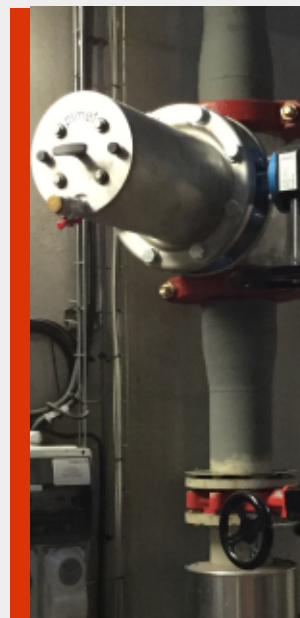
ByZon 100, exemple installation à la verticale
